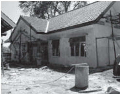
Kliniek in aanbouw
