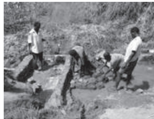
De bouw van waterputten in Peramiho
